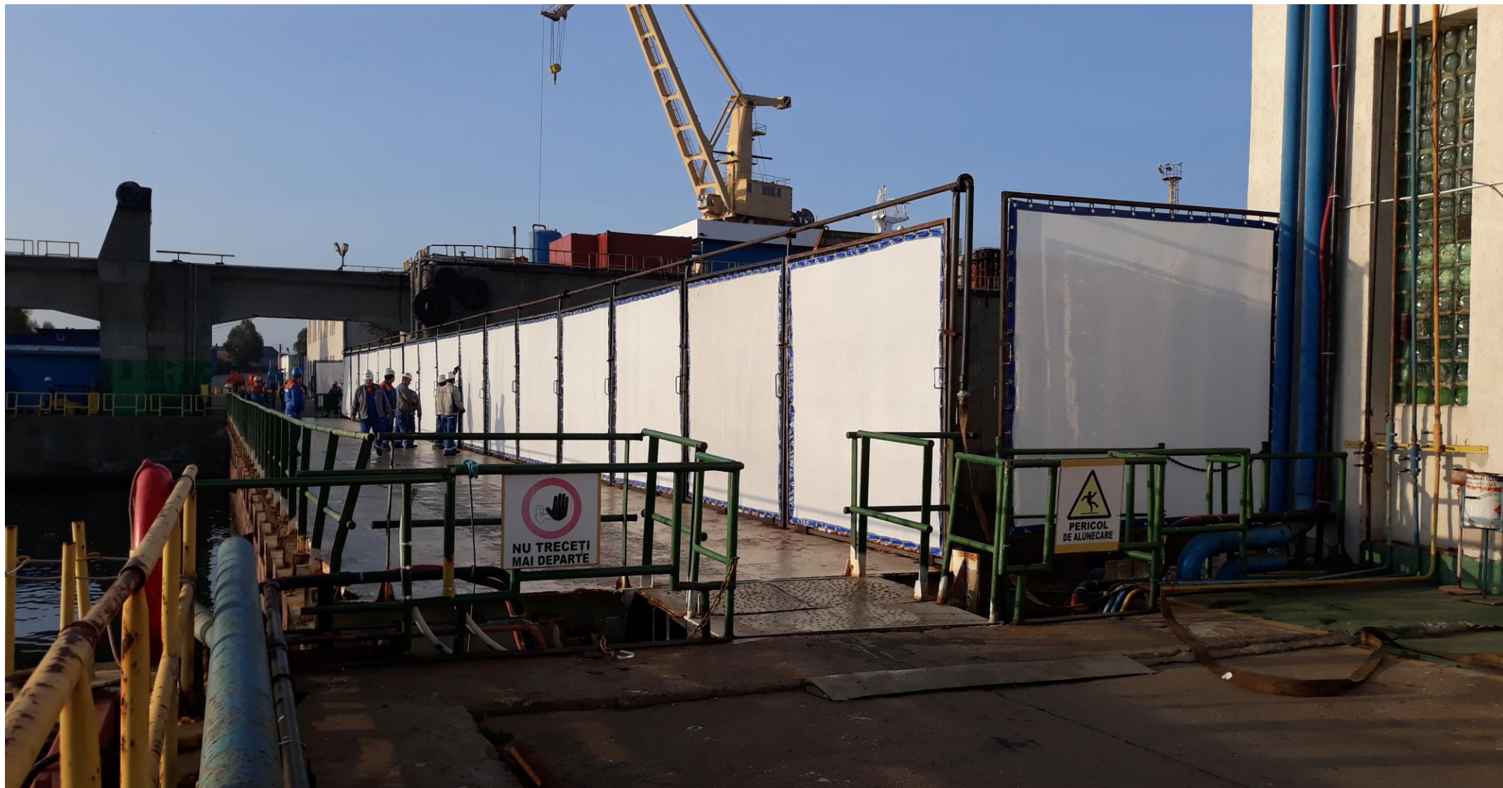
Sistemul de protectie si prevenire a poluarilor datorate activitatilor de sablare si vopsire a navelor din docul 2
